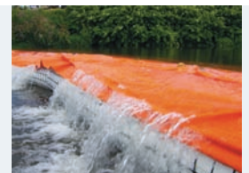
Standstabil bis zum Überströmen
